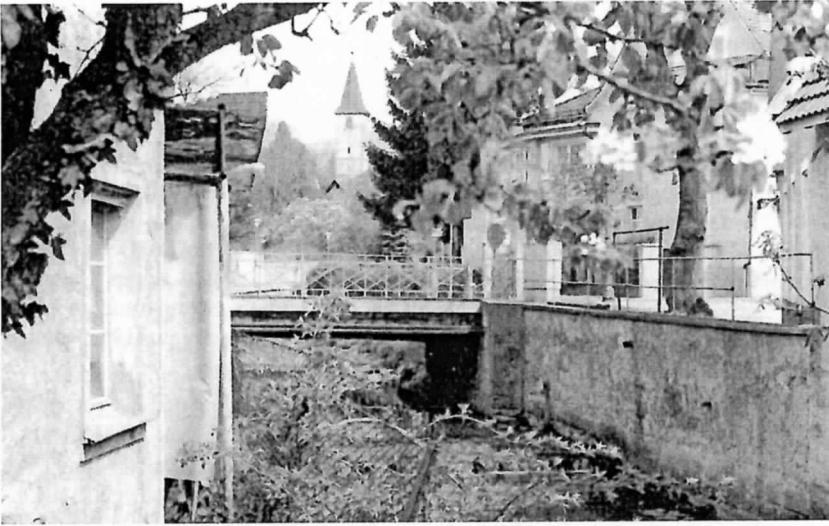
Abb. 1: Die „untere“ Brücke über den Klemmbach
