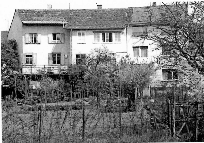
Abb. 7: Hauptstraße 98 (links) und 100 (rechts)
