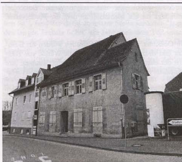
Das ehemalige jüdische Gemeindehaus Breisach Rheintorstrasse 3
