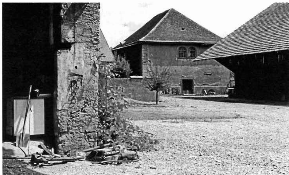
Das seinerzeit an den Vater der heutigen Eigentümerin veräusserte Synagogengebäude diente bis 1992 als Getreidespeicher. Eine Rettung des vom allmählichen Verfall bedrohten Gebäudes ist leider nicht zu erhoffen.
