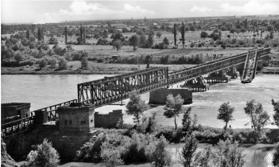
Abb. 3: Diese am 26. April 1941 in Freiburg aufgegebene Postkarte zeigt die Breisacher Eisenbahnbrücke nach ihrer am 25. Juli 1940 abgeschlossenen Wiederherstellung. Den auf französischer Seite gesprengten Brückenteil (rechts im Bild) hatte man im Wasser liegengelassen 36 . Vorlage: Stadtarchiv Breisach am Rhein.
