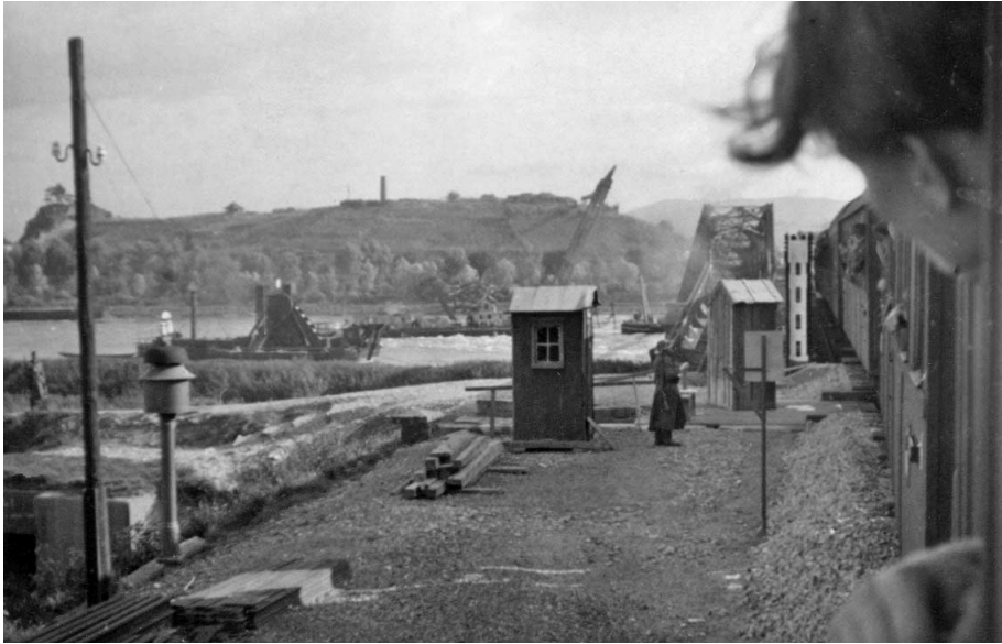
Abb. 5: Breisacher Rheinbrücke nach dem 25. Juli 1940, aus dem Zug fotografiert von der elsässischen Seite aus vor der Behelfsbrücke. Im Hintergrund der Eckartsberg, links von der wiederaufgebauten Eisenbahnbrücke sind die Trümmer der alten Brücke im Rhein zu sehen. Außerdem erkennt man zwei Wachhäuschen und zwei Soldaten. Die Aufnahme müsste perspektivisch von einem Zuginsassen gemacht worden sein. Vorlage: Stadtarchiv Breisach am Rhein.
