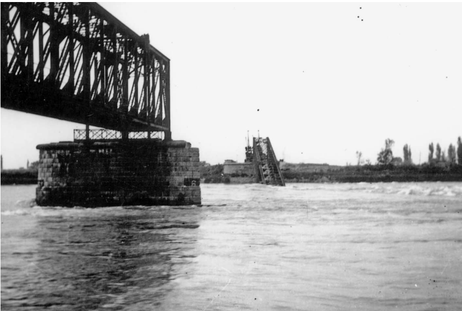
Abb. 2: Zerstörte Breisacher Brücke nach der am 20. Oktober 1939 erfolgten Sprengung durch deutsche Pioniere. Aufnahme von Rudolf Hanselmann, Breisach. Vorlage: Stadtarchiv Breisach am Rhein.
